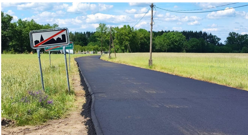
Nowa nawierzchnia drogi na odcinku Słocina – Podbrzezie Dolne
