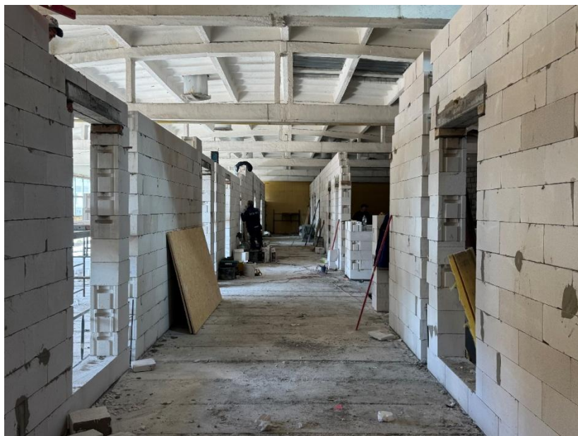
Branżowe Centrum Umiejętności – roboty budowlane
