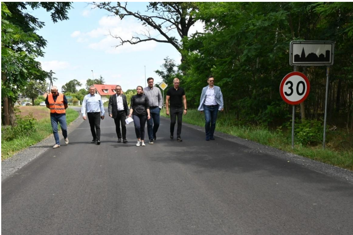
5 lipca 2024 r., Starosta Mariusz Stokłosa i Wicestarosta Tomasz Twardowski uczestniczyli w odbiorze wyremontowanej drogi powiatowej pomiędzy Słociną a Podbrzeziem Dolnym (gm. Koźuchów). Nowa nawierzchnia i utwardzone pobocze.
